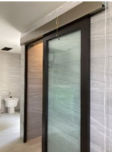
垃圾室電動橫拉門
